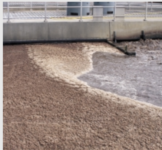
Fig. 31. Slam ved rensningsanlæg.
